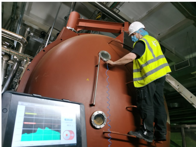
Рисунок 1 — Контроль соединений крупногабаритной камеры. Доступ к каждому участку и наблюдение за сигналом предусматривают при подготовке маршрута обследования.
